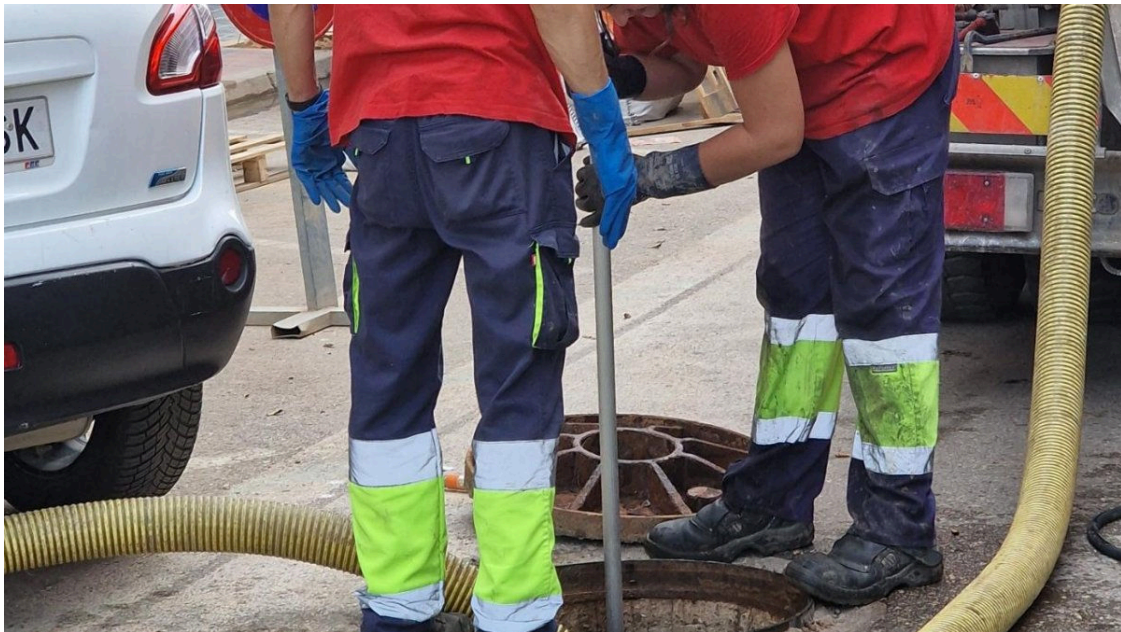
Trabajos de limpieza de alcantarillado
