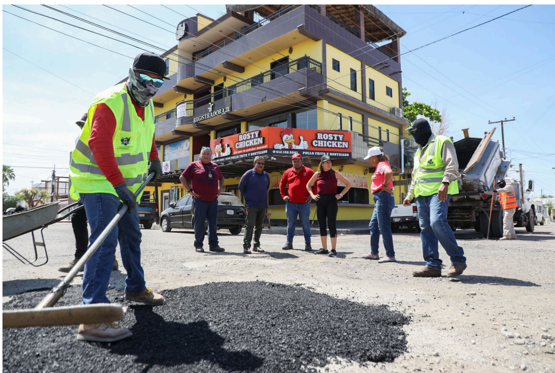
Cinco brigadas estatales y cinco municipales aplican bacheo con carpeta asfáltica y atienden derrames de aguas negras como parte del programa Reconstruyendo La Paz
